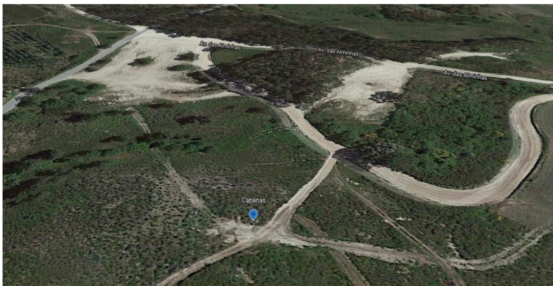
Figura 10 - Localização de Cabanas no planalto da Lameira, onde se pode observar o areal no canto superior esquerdo e os caminhos de terra batida (fonte: Google Earth ).
